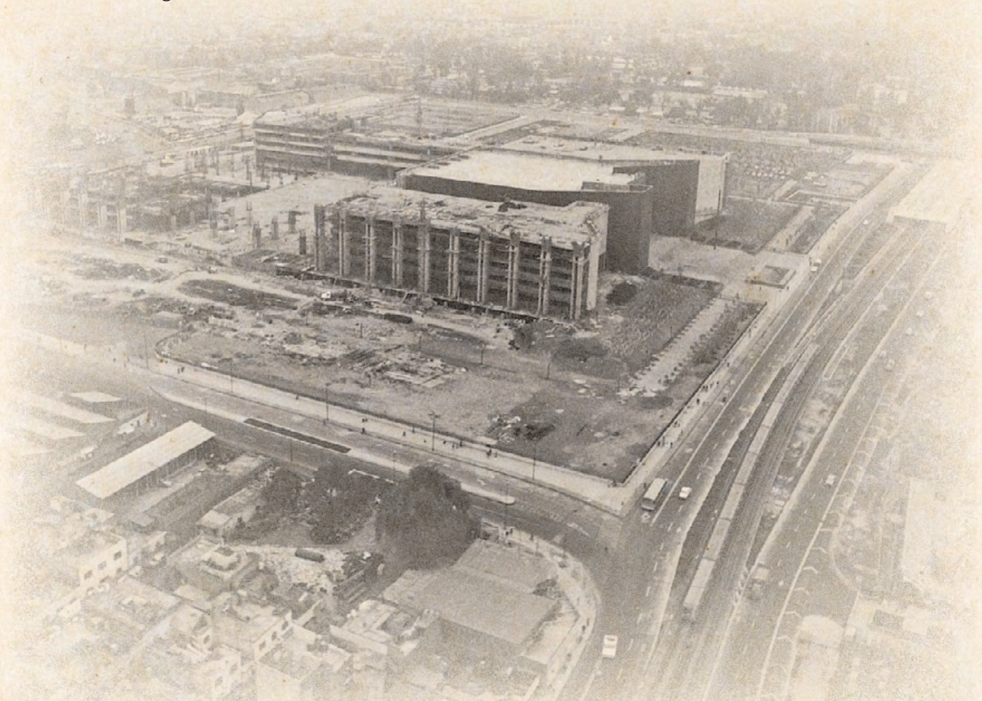
En la imagen se aprecia el Palacio Legislativo en construcción y las vías de acceso que lo rodean: Eje 2 Oriente, avenida Congreso de la Unión, que corre a contra flujo; Sidar y Rovirosa, así como la avenida Ingeniero Eduardo Molina y Emiliano Zapata Fuente Palacio Legislativo de San Lázaro XXX Aniversario 1981-2011
